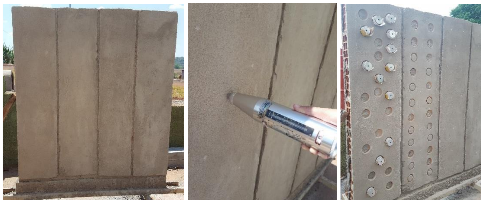
Figura 7 – Execução dos ensaios no estado endurecido Fonte: Própria autora (2019).
